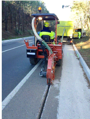
Exemple de treballs d'obertura de la microrasa
