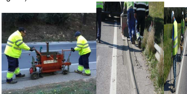
Exemple de treballs de rebliment de la rasa.
