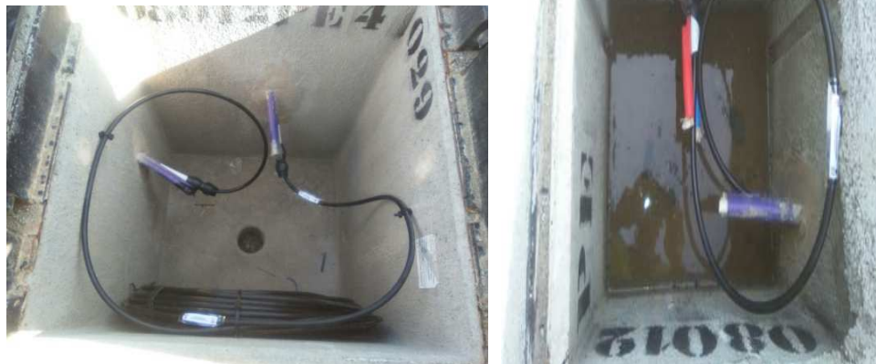
Exemples Terminació microductes en pericó
