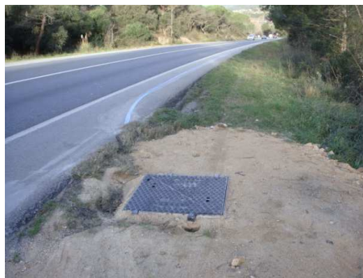
Exemple de l'estat de la canalització acabada
