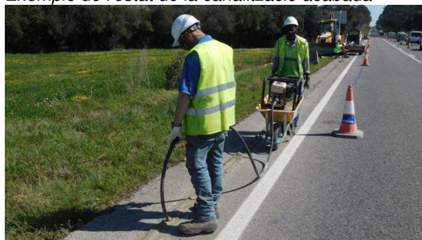
Procés de rebliment de la rasa amb morter.
