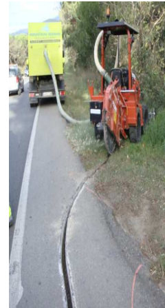
Gir de sortida de la calçada per col·locació d'un pericó
