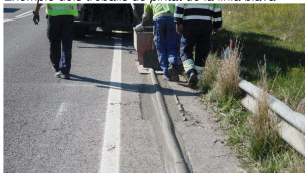
Procés de rebliment de la rasa amb morter.
