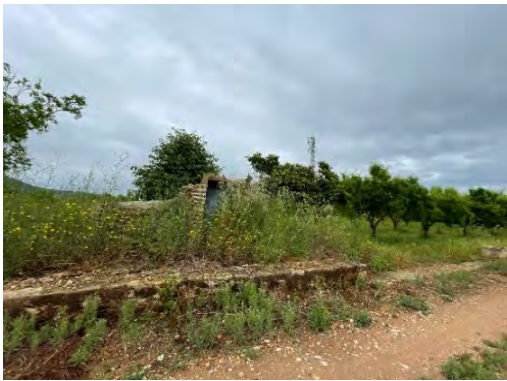
Imatge 25. Edificació agrícola abandonada al PK 0+520.
