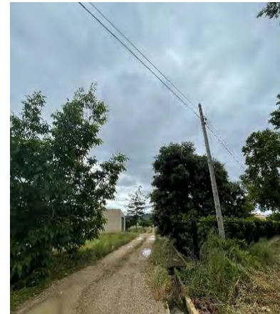
Imatge 30. Línia de telefonia al final del traçat de l'alternativa.
