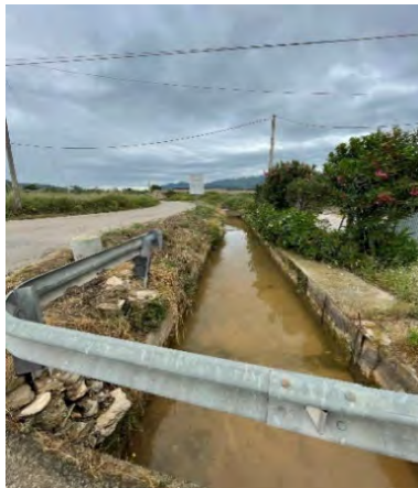
Imatge 36. Sèquia Mare a l'Avinguda de les Escoles.
