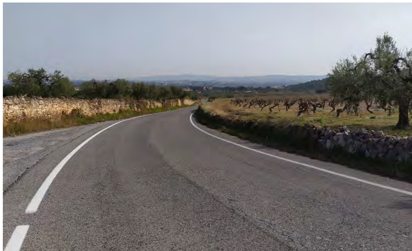
Figura 5. PK 0+850. Carretera actual deprimida respecte els terrenys adjacents i amb murs de pedra seca
