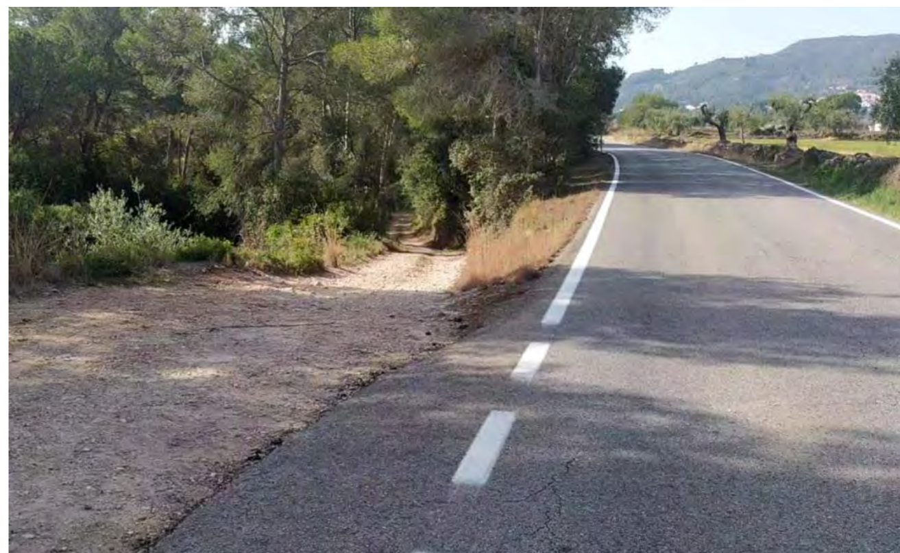
Figura 12. PK 2+020 amb camí municipal que connecta a Torrent de Mas de Manyer
