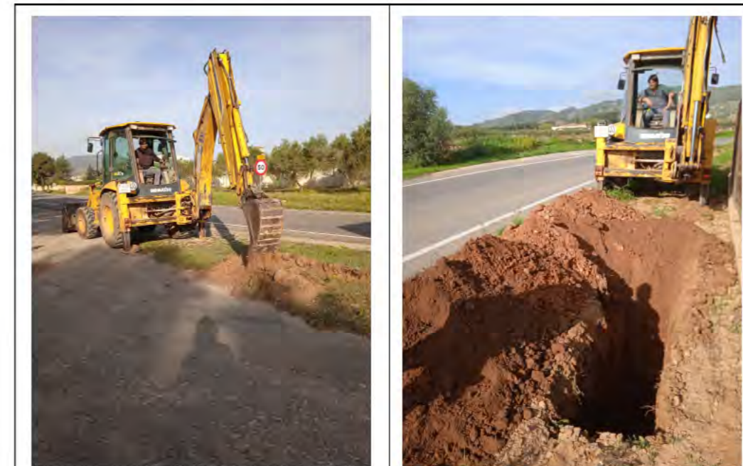
Retroexcavadora emprada i emplaçament de les cales C-1 i C-2, respectivament.
