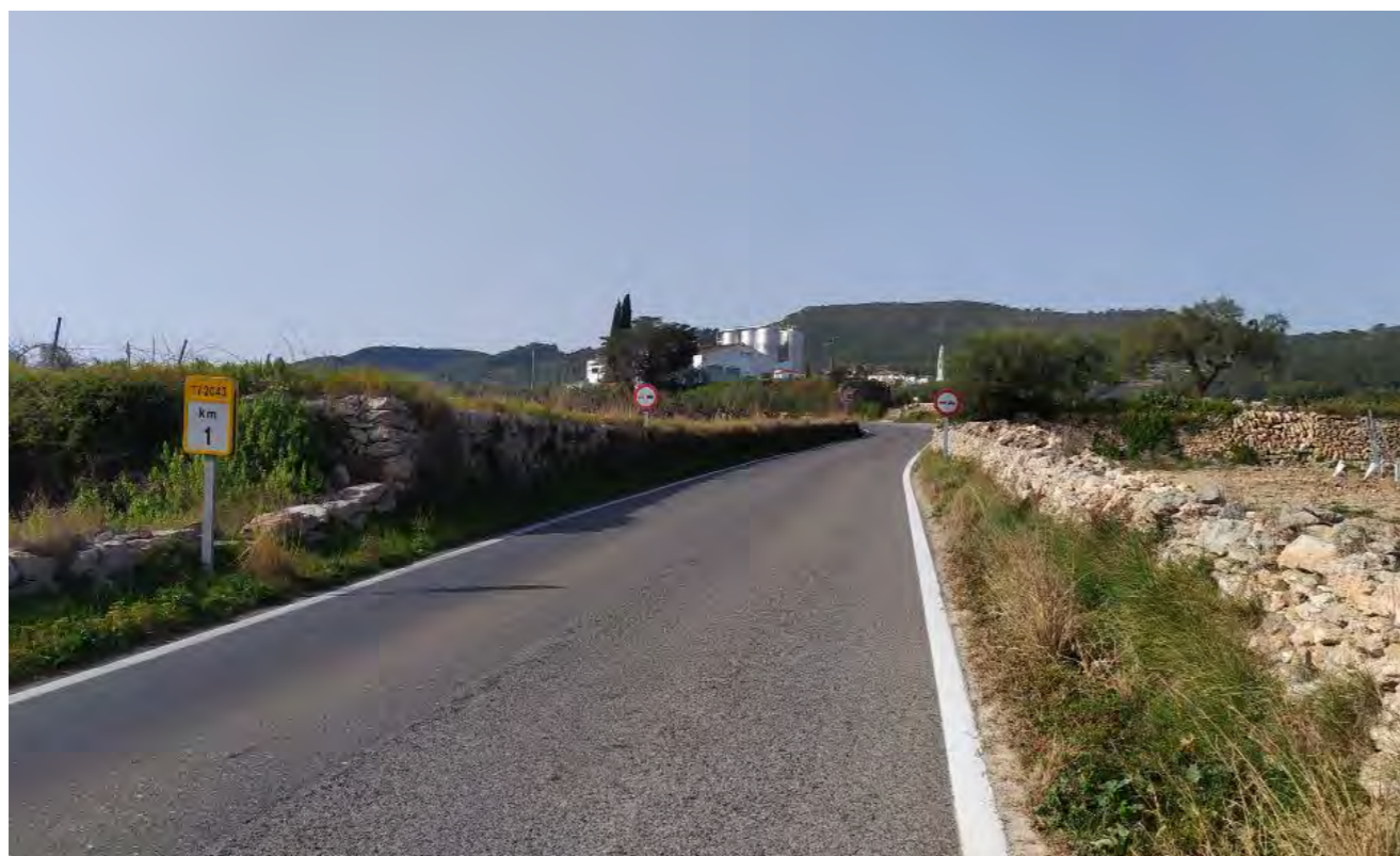
Figura 6. PK 1+000 de la carretera actual
