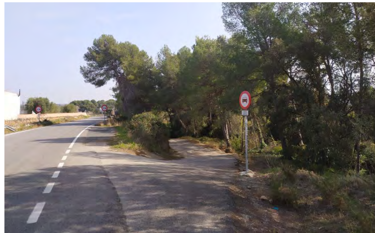
Figura 15. PK 2+220 amb camí urbanització la Papiola al marge dret
