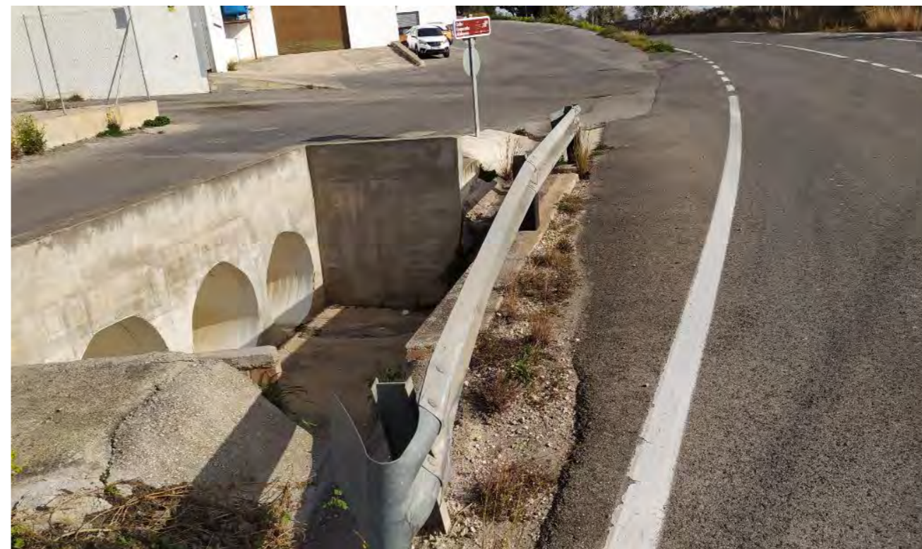
Figura 3. Obra de fàbrica existent ubicada al PK 0+720
