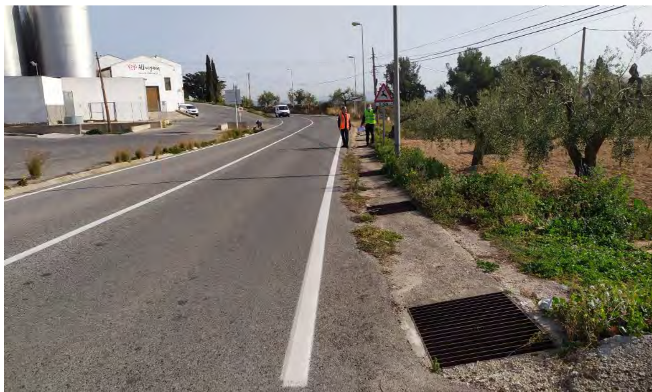
Figura 2. Vista general del vial a l'inici del tram
