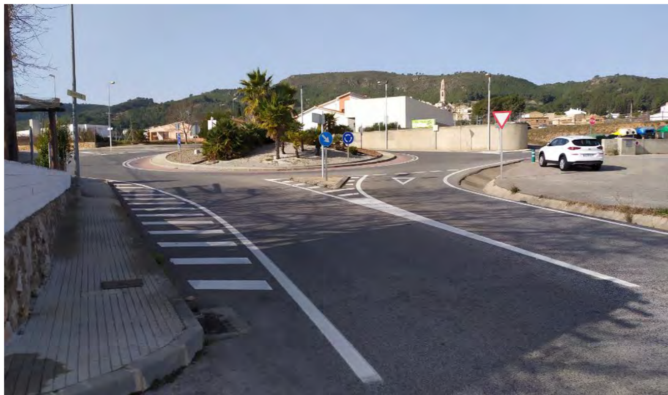
Figura 1. Vista general del vial a l'inici del tram
