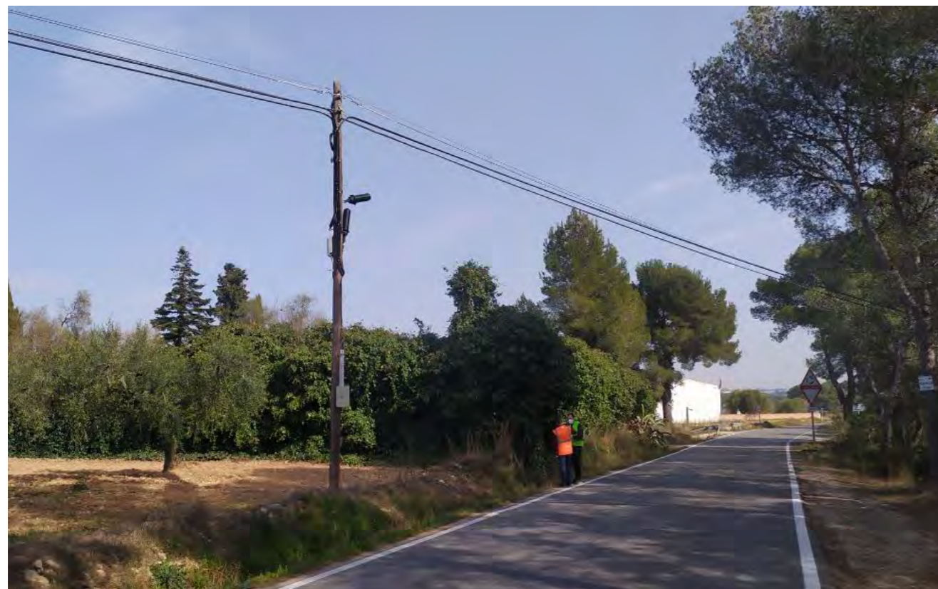
Figura 13. Suport Telèfonic afectat per la nova traça. PK 2+150
