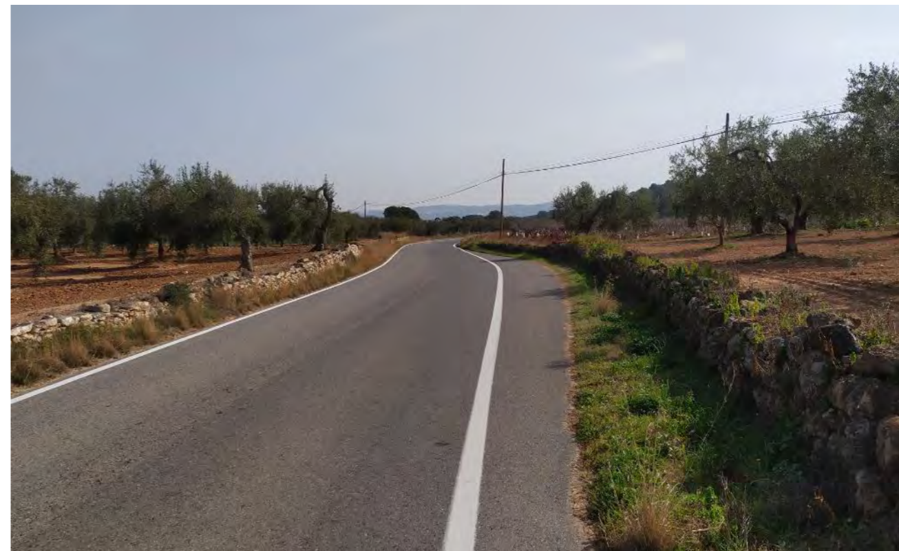
Figura 7. PK 1+300 de la carretera actual amb presència murs pedra seca i suport de Telefònica al fons afectat per la nova traça
