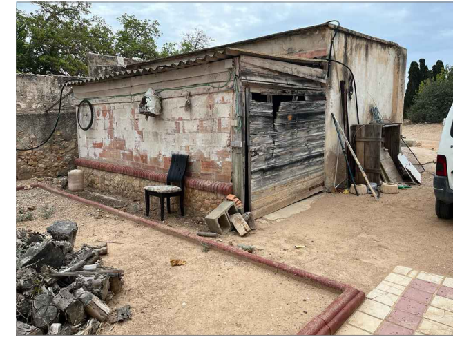
MAGATZEM. CANTONADA NORD-OEST
