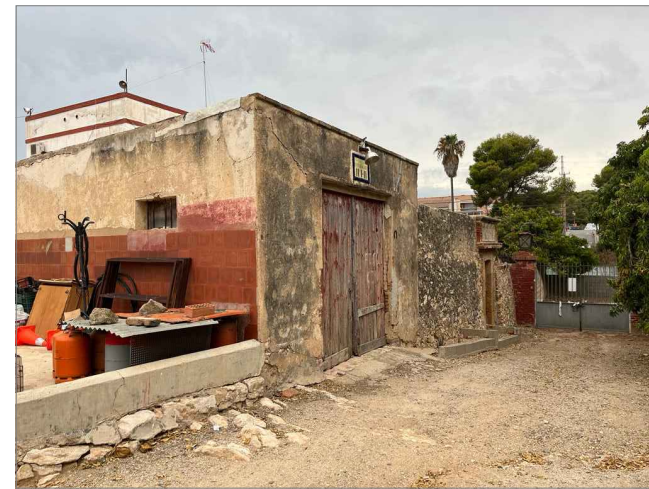
MAGATZEM. CANTONADA SUD-OEST
