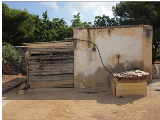
MAGATZEM. FAÇANA OEST
