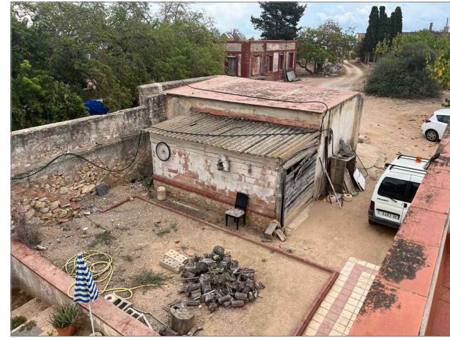
MAGATZEM. CANTONADA NORD-OEST
