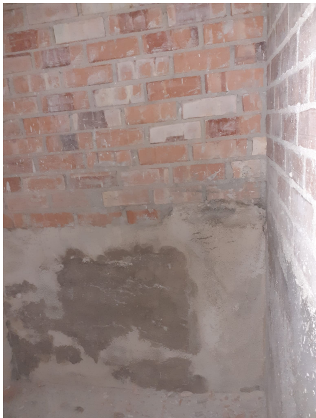
Fotografia 1. Foso i forat de l'ascensor existent.
