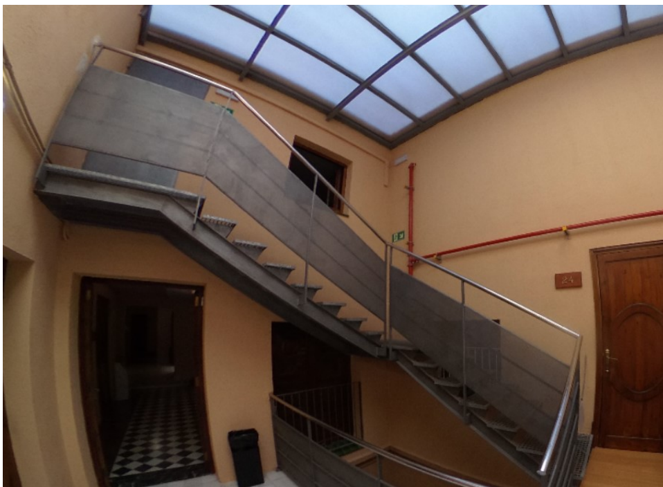
Fotografia: Estat actual de la barana "B"
