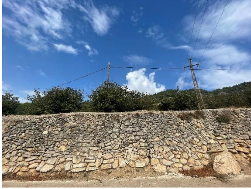
Fotografia 5. Presència de línies elèctriques i murs de pedra seca.
