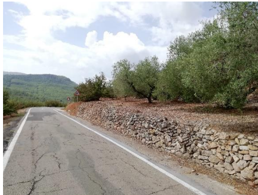
Fotografia 4. Marge de la carretera delimitat per murs de pedra seca.
