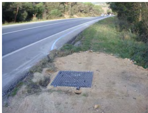
Exemple de l'estat de la canalització acabada
