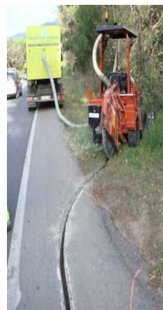
Gir de sortida de la calçada per col·locació d'un pericó
