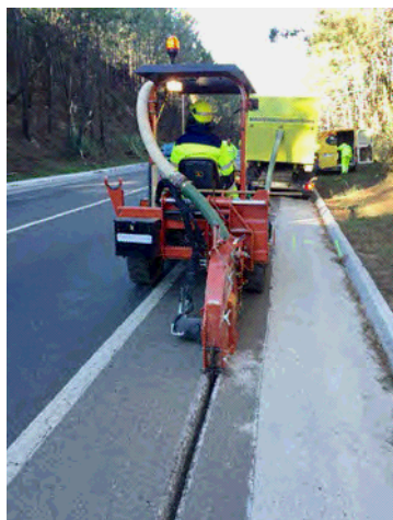
Exemple de treballs d'obertura de la microrasa
