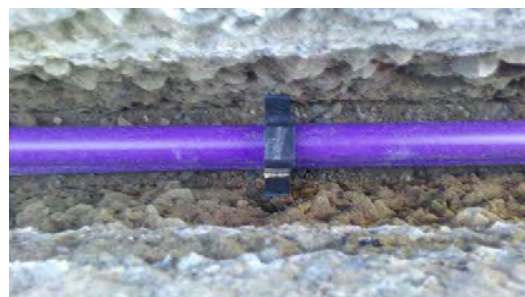
Centrador plàstic per homogenitzar la distribució del morter.
