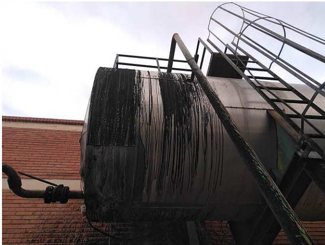
Figura 20 Vista del dipòsit, l'escala i la plataforma
