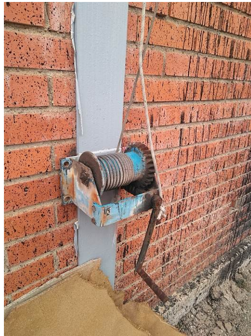
Figura 23 Vista de la manovella de la politja ancorada a la paret de la nau
