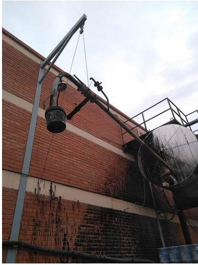
Figura 24 Vista del sistema de politja per a orientar la canonada de sortida del dipòsit
