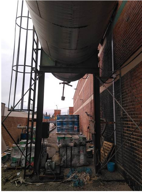
Figura 16 Figura 17 Vistes de l'estructura portant del dipòsit
