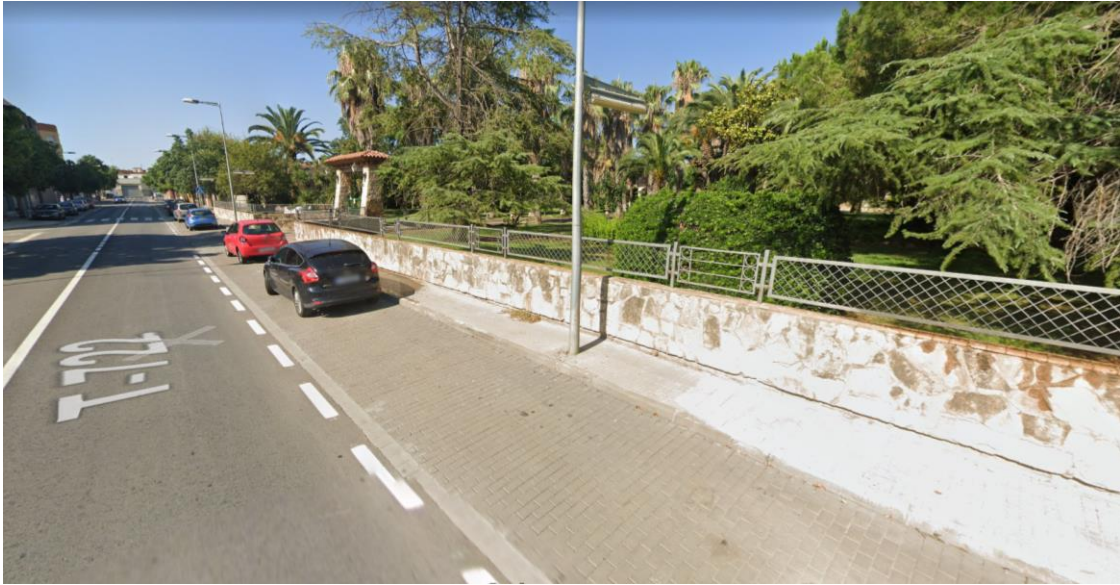
Av. de Valls i costat oest de l'àmbit
