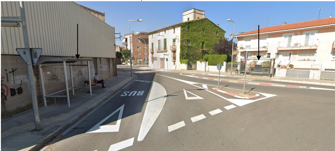
Foto 7. Marquesines Av. Valls-C. St. Rafael.
